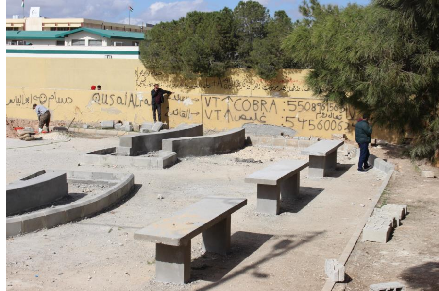
During photo صورة أثناء التنفيذ
