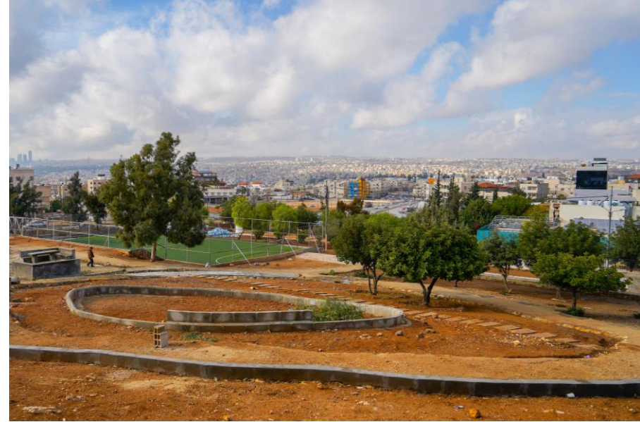
During photo صورة أثناء التنفيذ
