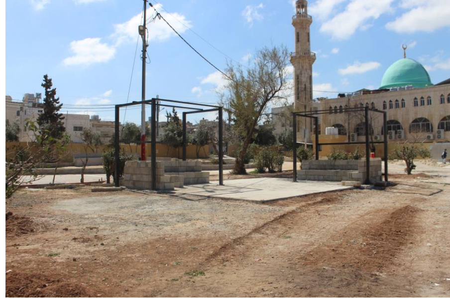
During photo صورة أثناء التنفيذ
