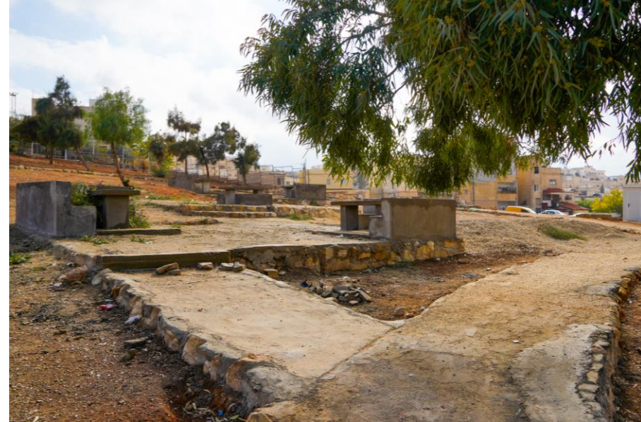
During photo صورة أثناء التنفيذ
